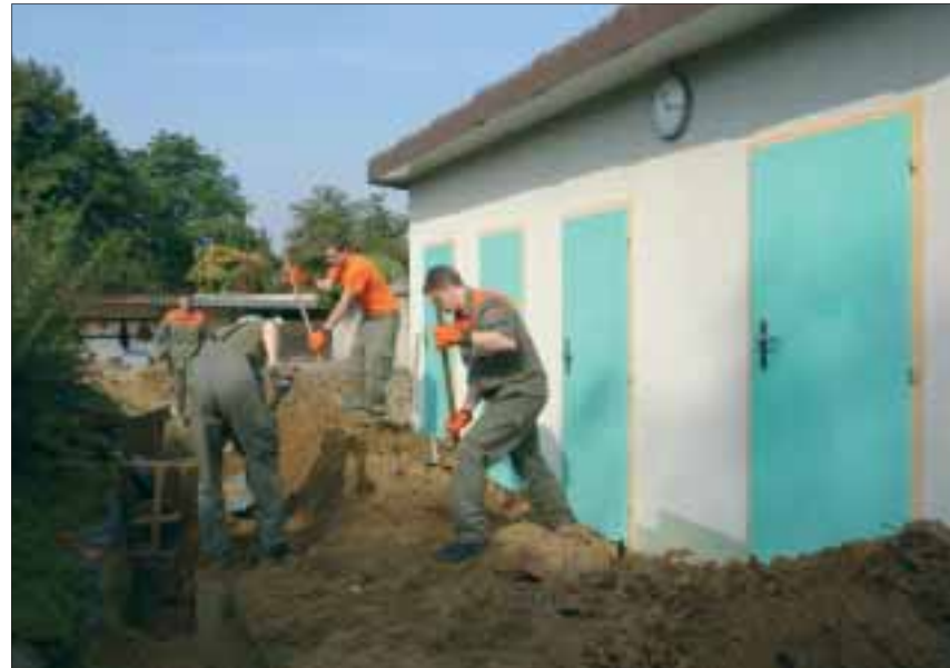
Neue Wasserleitung: Ein 30 Meter langer Graben musste ausgehoben werden.
