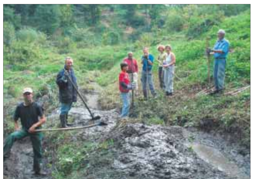
Reinigung: Die Einlaufbecken werden von Schlamm und Geschiebe befreit. Foto: E. Hunziker
