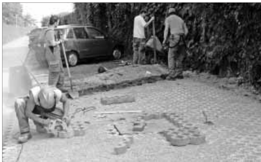
Zivilschutzinsatz: 15 Laufmeter Parkplätze werden verlegt. Foto: Hp. Blattner
